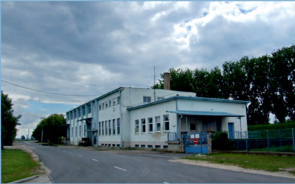
A hármashídi vízműtelep épülete Székesfehérváron (2013)
