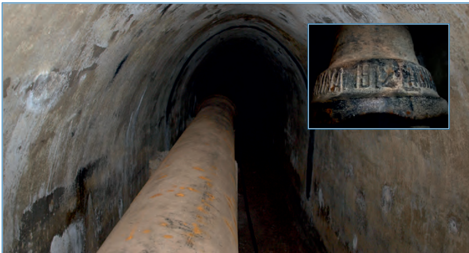
A víztermelő kutakat összekötő vákuumcső. Fent: A cső illesztésénél feltüntetett gyártási év: 1912
