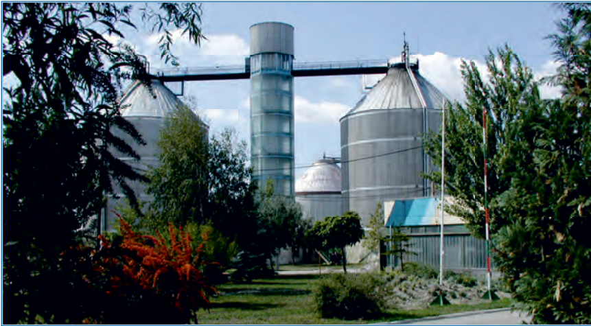
A központi szennyvíztisztító-telep iszapfermentáló tornyai (2000)
