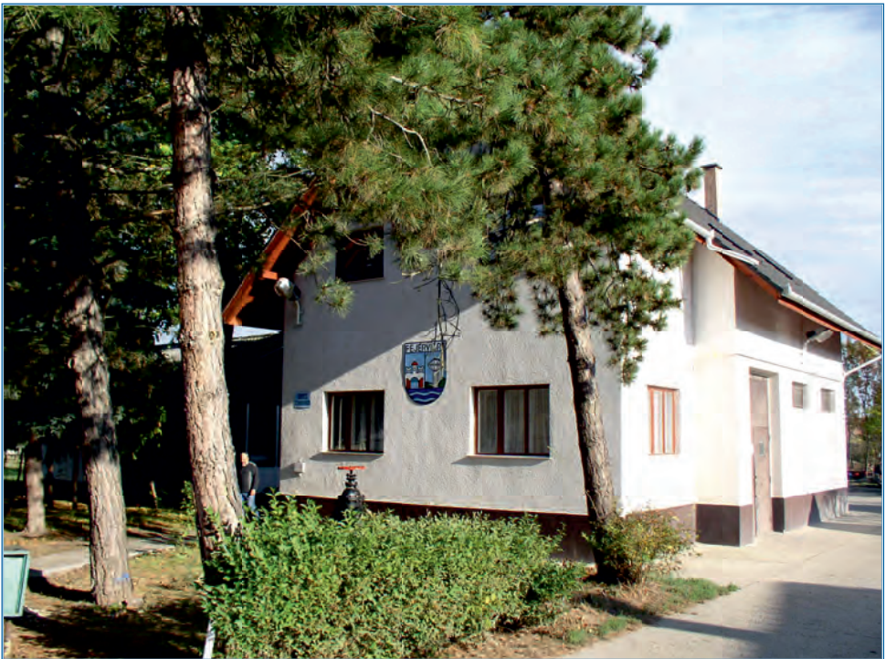
A Bicskei Üzemmérnökség épülete
