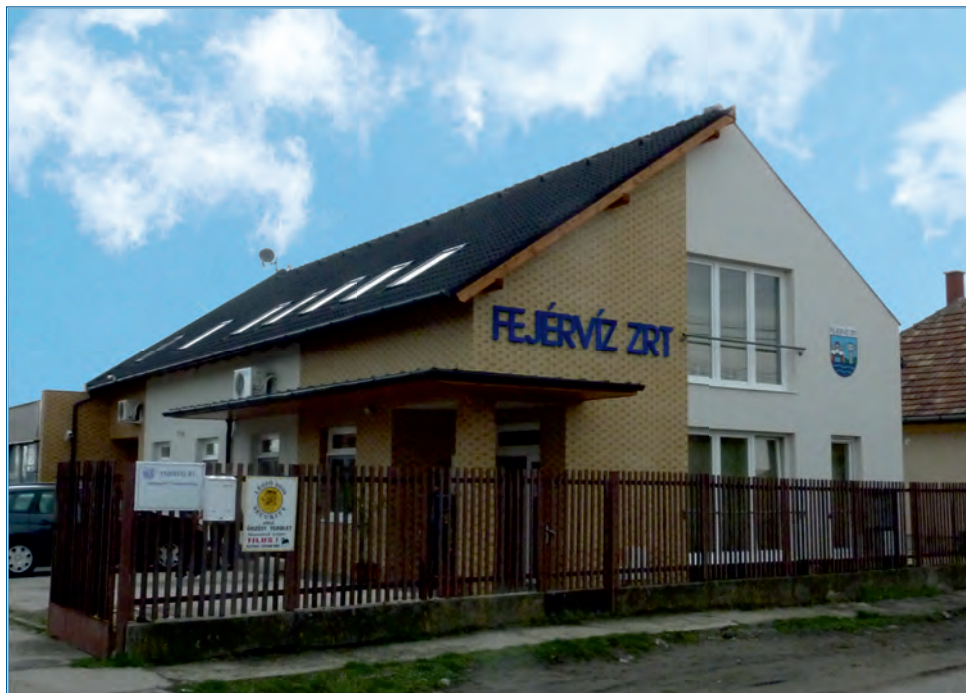
A Sárbogárdi Üzemélnökség épülete
