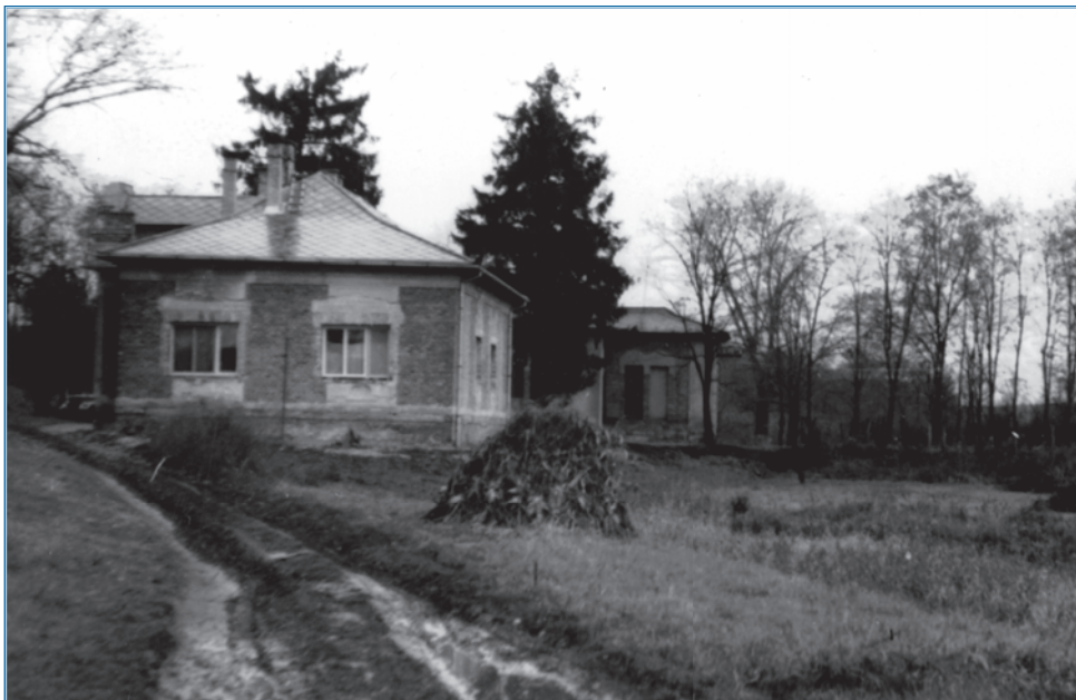
Az aszalvölgyi vízmű bejárata (1960-as évek)
