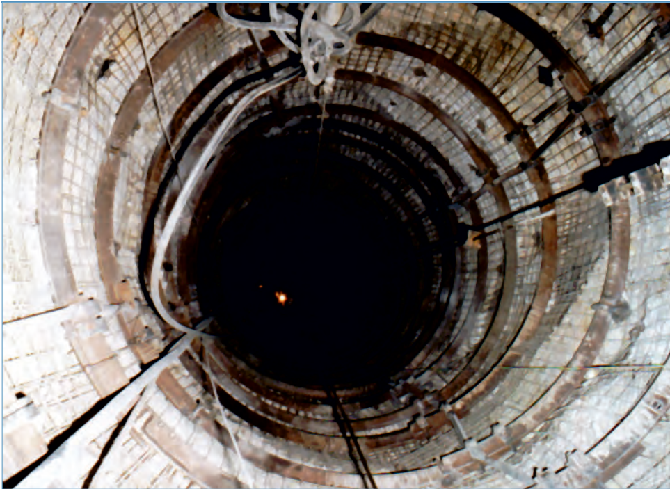
A karsztakna mélyítése Csóron (1997)
