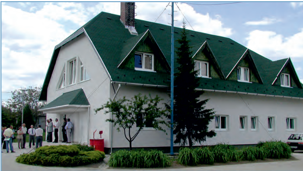
A Móri Üzemmnökség épülete
